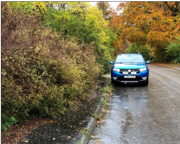
Överhängande växtlighet på Spångahusvägens norra trottoar.
