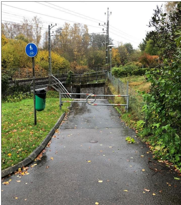
Tunnel under järnvägen i Sjöboholmsvägens västra ände med endast en trappa, skyltad som gång- och cykelväg.
